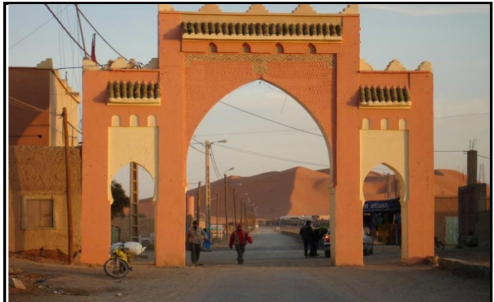
Figure1.9. La porte de Merzouga / Source. http://surlarouteadeux.canalblog.com/albums/sur_les_routes_du_maroc/photos/105438194-merzouga_la_porte_des_sables.html
