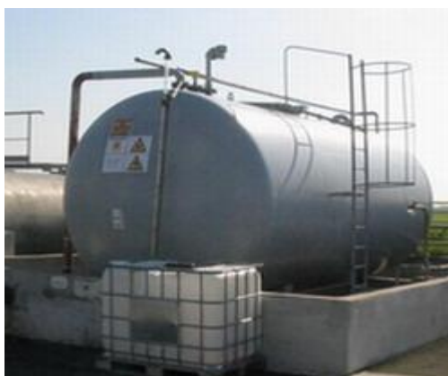
Fig.I.5. Cuve à toit fixe.
