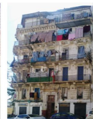
Figure 00: Façade neoclassique 02 Source: photo prise par les autrices
