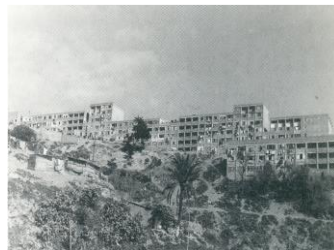
Figure 34 immeuble de Carrière Jaubert
