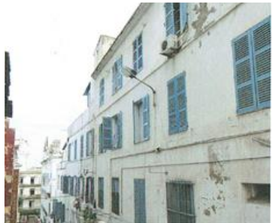
Figure 39 maison de rapport a cour (Rue Hariched-Ali)
