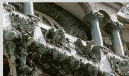
Figure 44 façade de style Art nouveau
