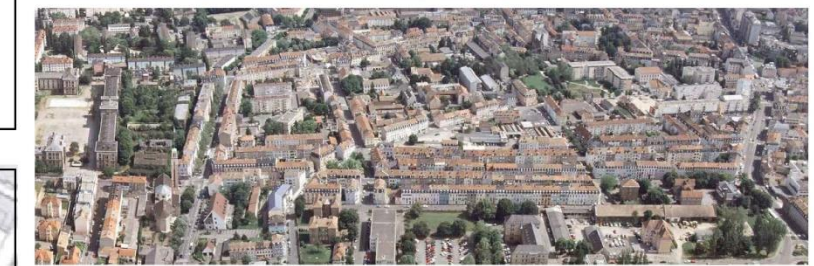
Figure 07 :vue ancienne du quartier Vauban-Neppert-Sellier Source : Protocole de préfiguration Mulhouse Alsace agglomération du projet de renouvellement urbain, mars 2016
