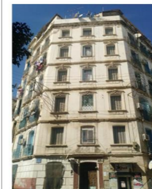
Figure 00: Façade Neoclassique 01 Source: photo prise par les autrices
