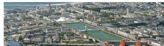
Figure 00 : Vue aérienne sur le bassin de commerce source : Google image
