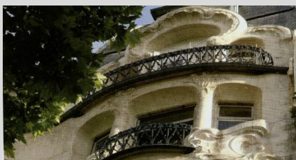
Figure 43 Façade de style Art nouveau
