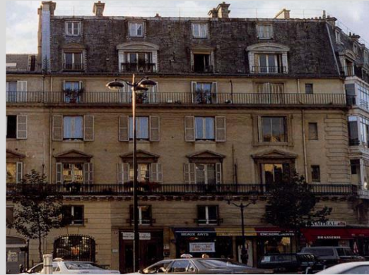
Figure 37 Façade de style néoclassique
