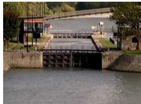
Figure 11 : Exemple d'une écluse. Source : Le fonctionnement des écluses-Jeulin TV
