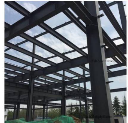
Figure 64 : Vue sur une charpente métallique en cours de réalisation
