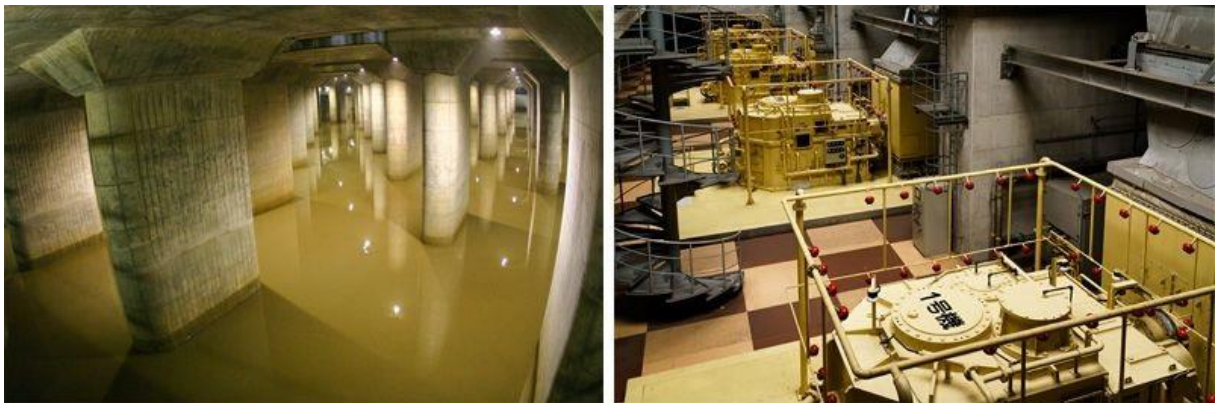
Figure 14 : Exemple d'un bassin de rétention à Tokyo, Source : nippon.com
