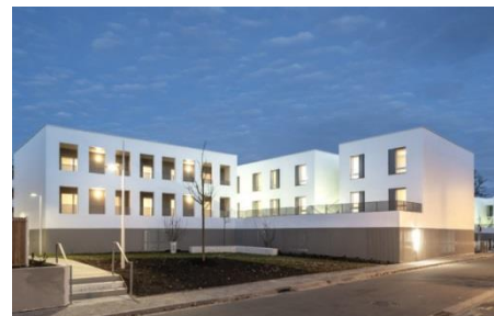
Figure 34 façade sud du bâtiment B
