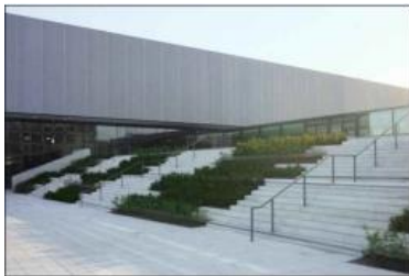
Figure 47 illustration sur escaliers urbains
