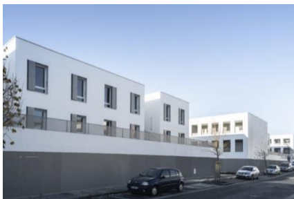
Figure 33 façade nord du bâtiment C
