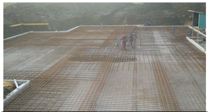
Figure 93 : Fondation en radier en travaux
