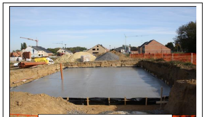
Figure 88 : Coulage du béton
