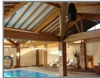
Structure en bois « piscine couverte »
