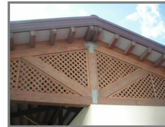
Charpente en bois « lamellé collé »
