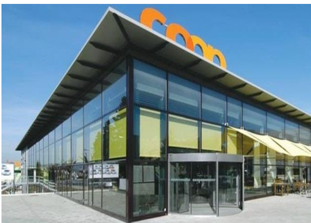
Figure 55 Lignes arrangées et transparence des façades. Source: https://archiguelma.blogspot.com/
