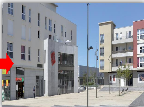
Figure 34 vue sur les nouveaux bâtiments (bâtiments mixtes) Source : www.ville-boulogne-sur-mer.fr
