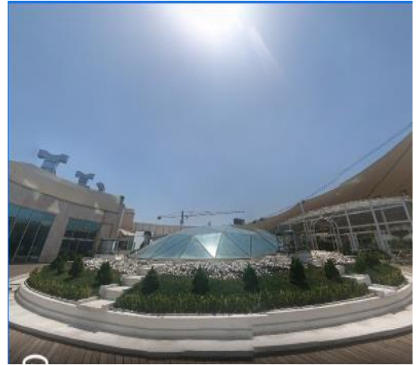
Figure 14 Vue extérieure sur le vide centrale .Source : https://www.google.dz/maps/place/Arg+Shopping+Center
