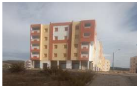
Figure 84Habitat intégrés du côté nord -ouest de site . Source:prise par l'auteur
