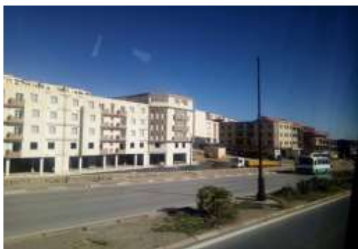
Figure 83Habitat intégrés et maisons individuel sur le parcours territoriale. Source prise par l'auteur.
