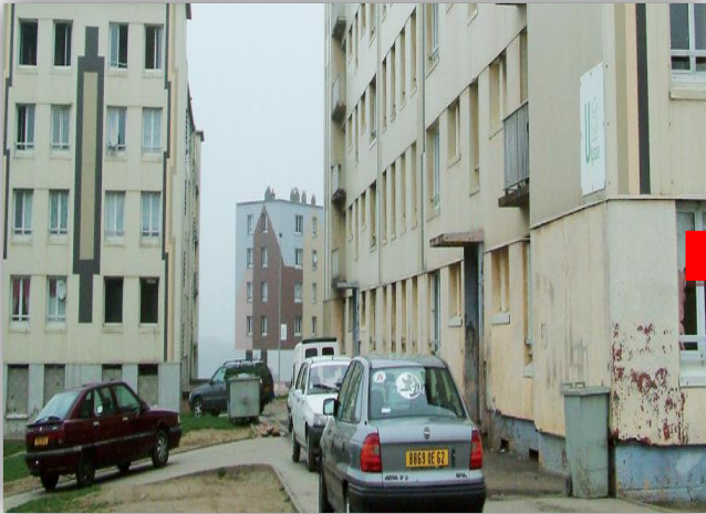
Figure 28 Vue sur les anciens bâtis Source : www.ville-boulogne-sur-mer.fr
