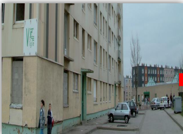
Figure 33 vue sur les anciennes bâtiments (logement jusqu'au RDC . Source : www.ville-boulogne-sur-mer.fr
