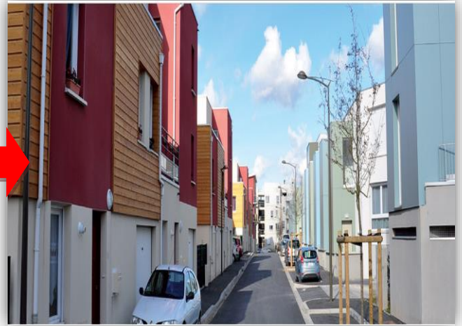
Figure 29 vue sur les nouveaux bâtis .Source : www.ville-boulogne-mer.fr -sur-fr
