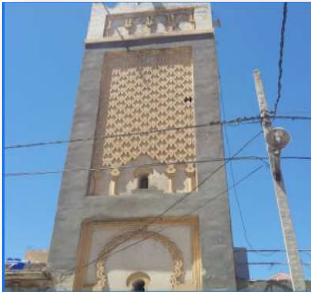
Figure 66 Vue sur le minaret. Source : Google pro
