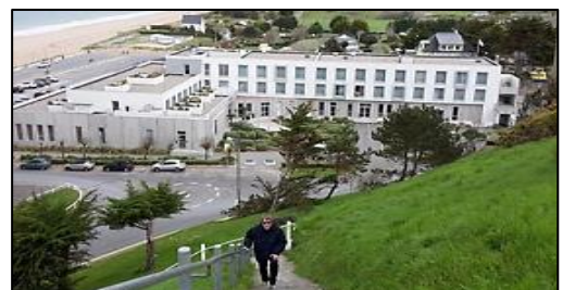
Figure3- 62: vue sur les parvis
