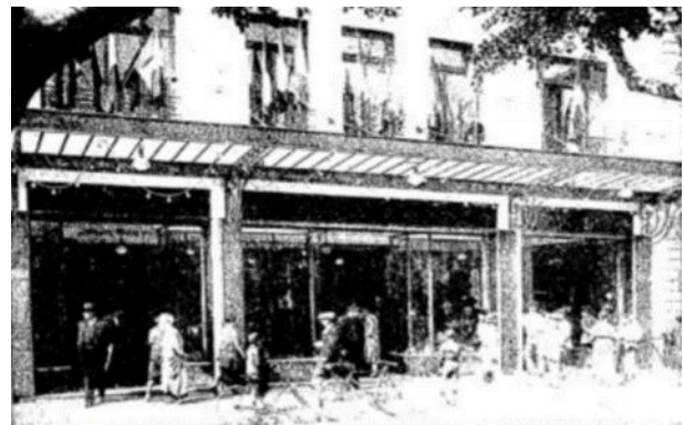
Figure 72. — Vue générale des vitrines, rue Bertagna, Bône.
