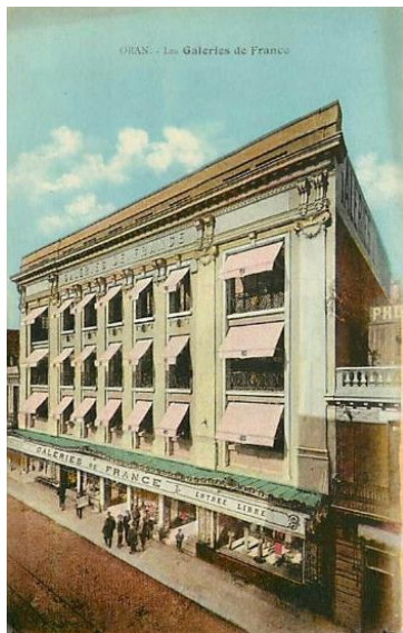
Figure 69. — Galeries de France, Rue d'Arzew, Oran.
