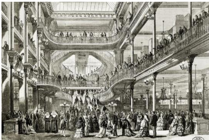
Figure 24. – "Au Bon Marché", hall et grand escalier, 1879.
