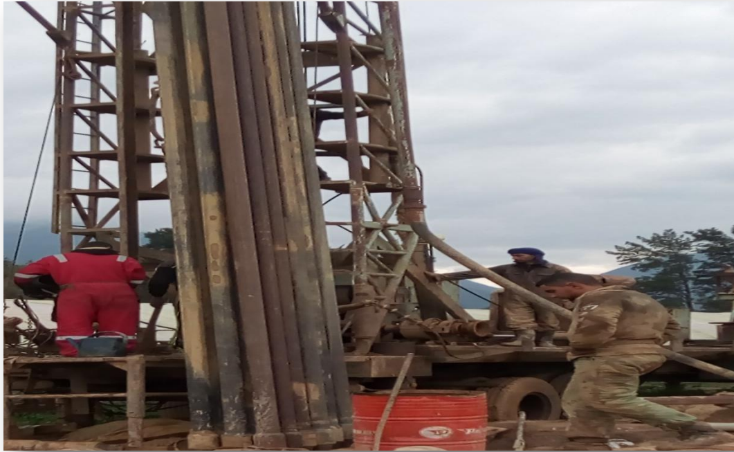
Figure. III-11 : Photo de tiges forage
