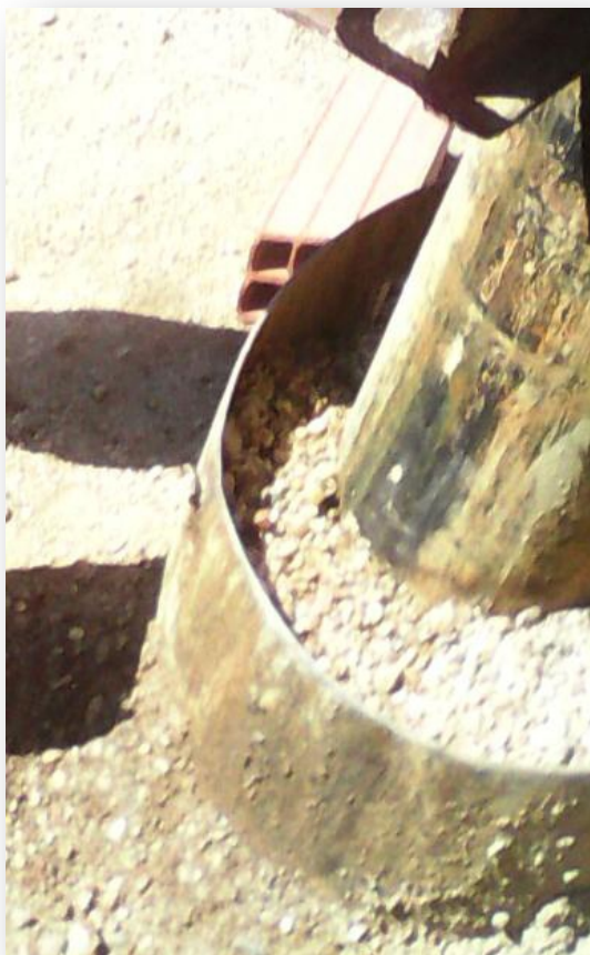
Figure IV-20 : Mise en place du massif filtrant.
