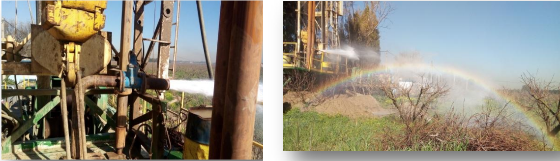
Figure IV-24: Opération de développement à l'air lift du captage (vanne ouvert)
