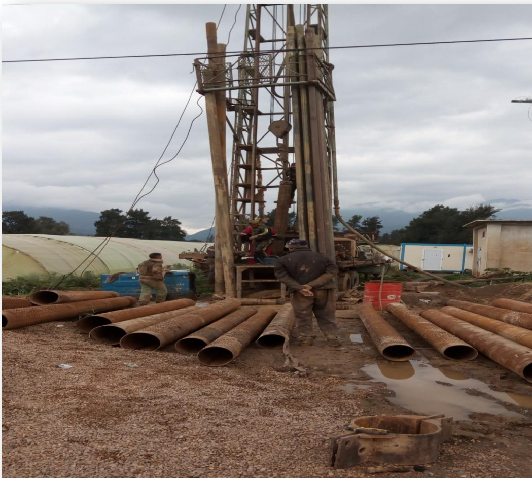
Figure IV-11 : Photo mise en place du tubage
