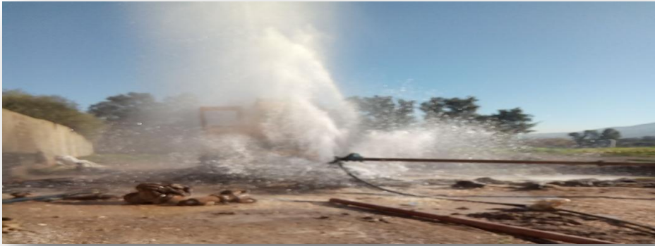
Figure IV-26: Opération de développement à l'air lift du captage (vanne ouvert)
