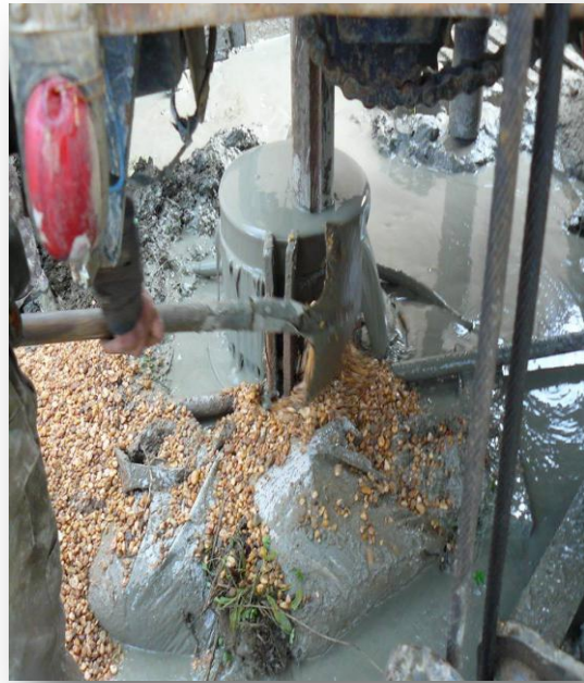
Figure IV-19 : Gravier additionnel du massif filtrant
