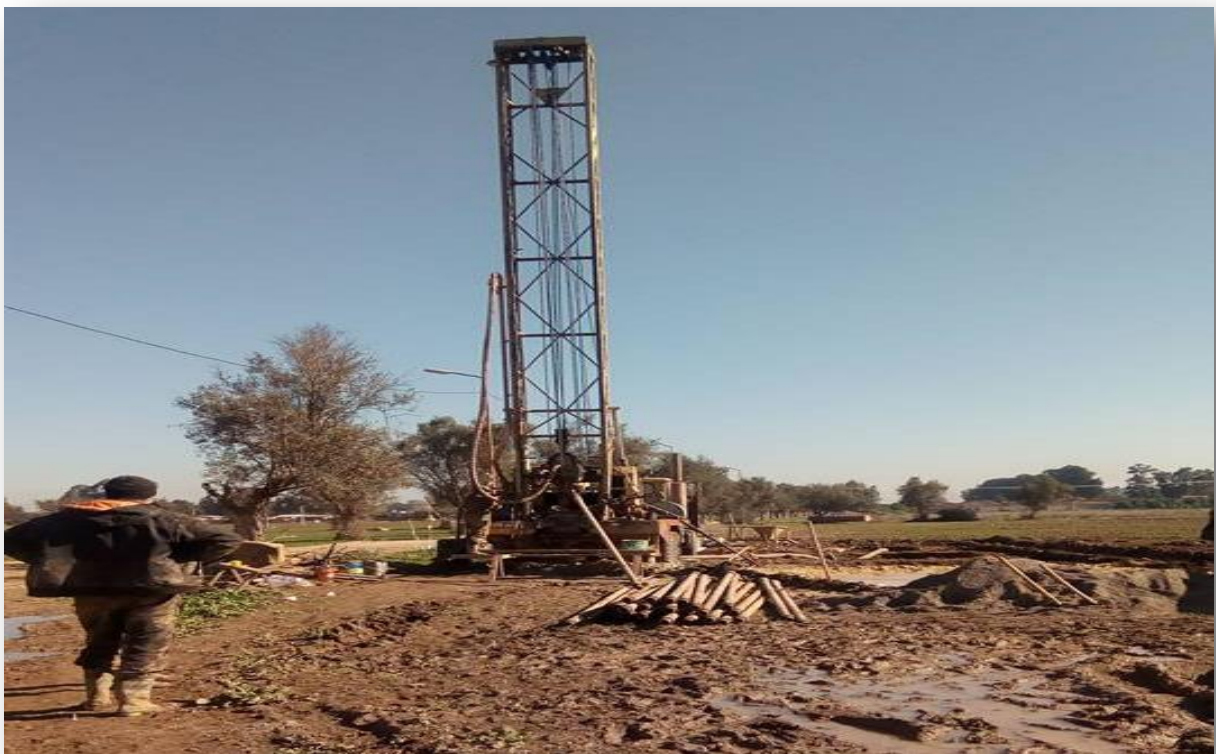
Figure IV-5 : Illustration de l'opération de creusement
