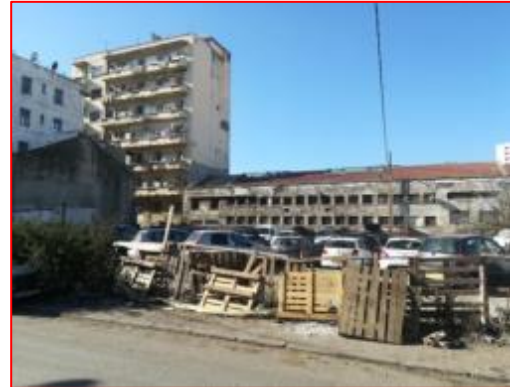
Figure 3.56: HC au niveau Rue Rochai
