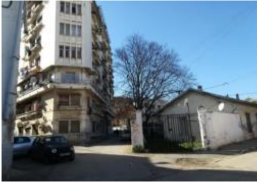
Figure 3.51: HC au niveau Rue rochai
