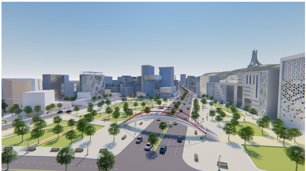
Figure 3.93:vue sur air d'intervention après l'aménagement.
