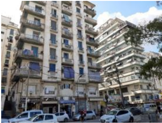
Figure 3.72: HC au niveau Rue Hassiba
