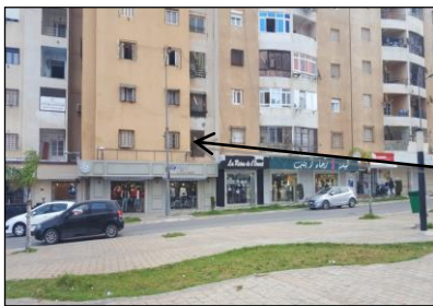
Figure 97 : Photo : Vue sur les logements avec commerces en RDC Sur la rue akid lotfi Source : auteur
