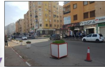
Figure 82 : Photo : Rue périphérique n 2
