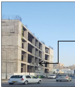
Figure 93 : Photo : Rue périphérique n 2
