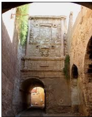
Figure 18 : Photo : La porte d'espagnole
