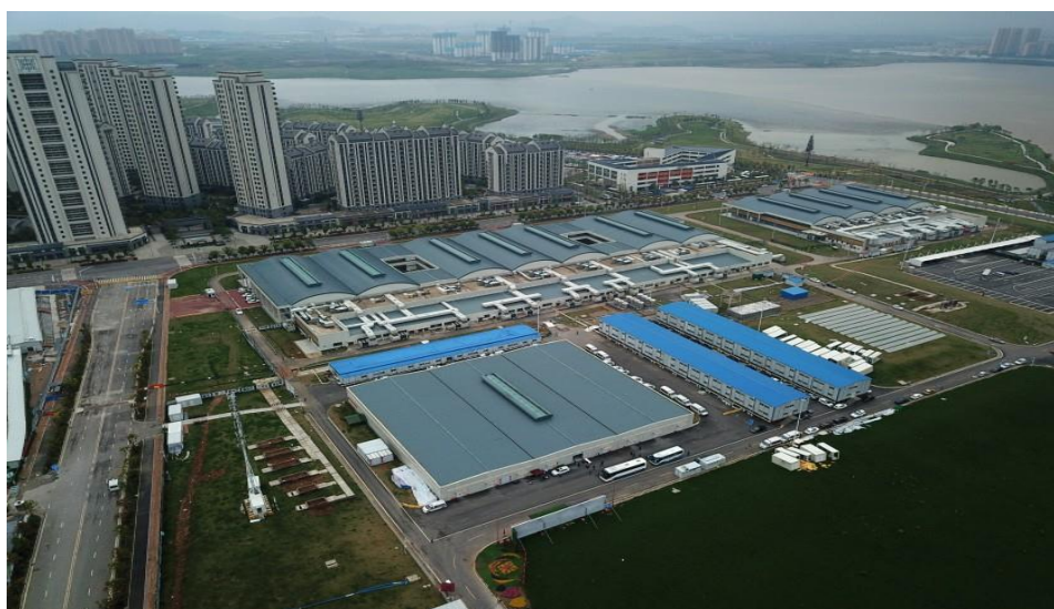
Figure 4 : Photo : L'hôpital de Leishenshan a été construit sur un parking à partir de modules préfabriqués en deux semaines à Wuhan, en Chine. (Sam McNeil / Associated Press)
