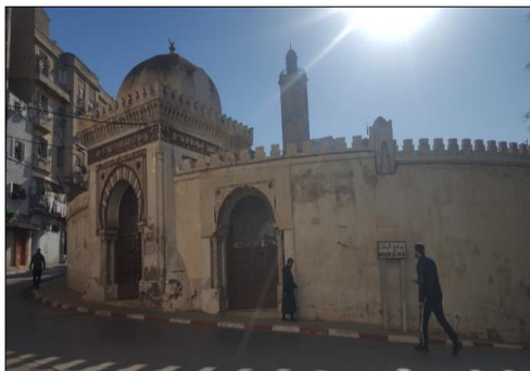
Figure 27 : Photo : La mosquée Hassan Pacha
