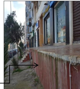
Figure 94 : Photo : Rue périphérique n 2
