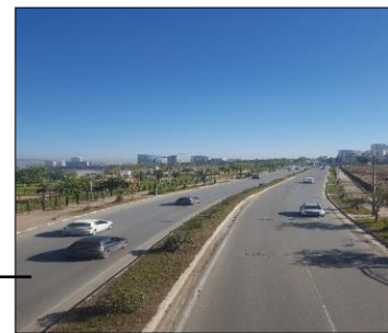
Figure 107 : Photo : CW n°75
