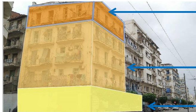
Fig 134: Façade d'un immeuble sur la rue Tripoli Source : prise par auteur le 26.10.2019, traité par auteur
