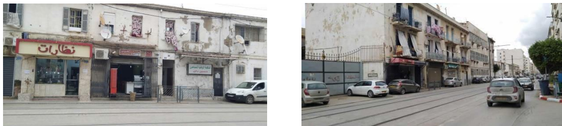
Fig 144-145: La façade de site coté rue de tripoli Source : prise par auteur 04/04/2020
