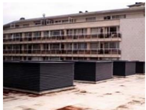
Fig211 : ventilation naturelle basée sur l'effet cheminé
