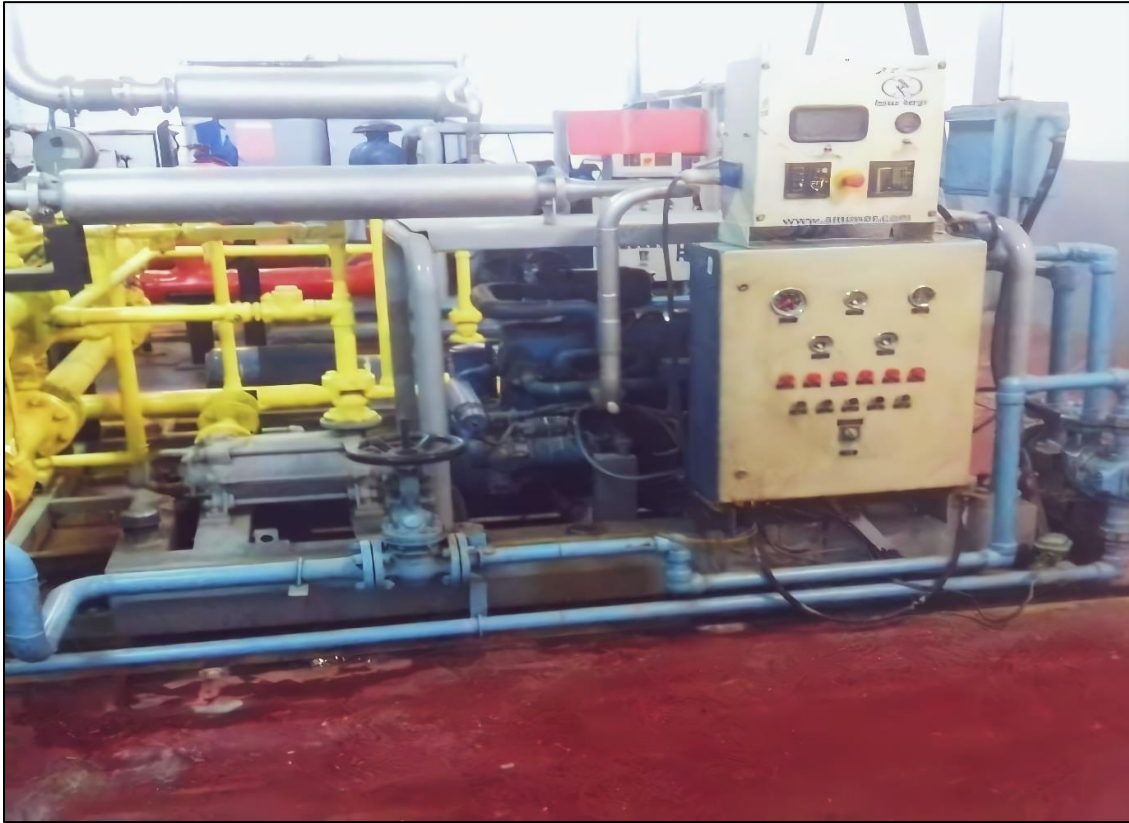
Figure II-19 : Pompe à mousse R330B (moteur diesel)
