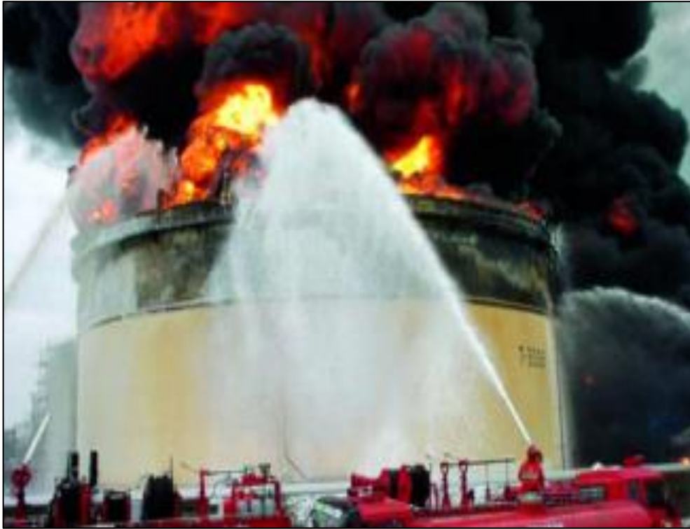
Figure II-17 : Refroidissement du bac de stockage[19]
