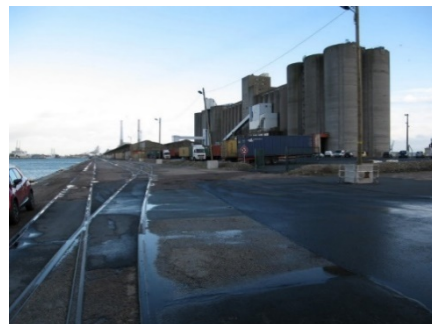
Figure 05 : route du Môle central Source : Pierre Thorez, 2014
