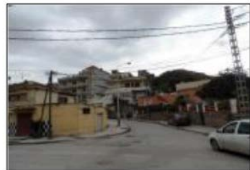
Figure 84 : Photo de la rue Khettab Youcef. Source : APC d'El Mohammédia.
