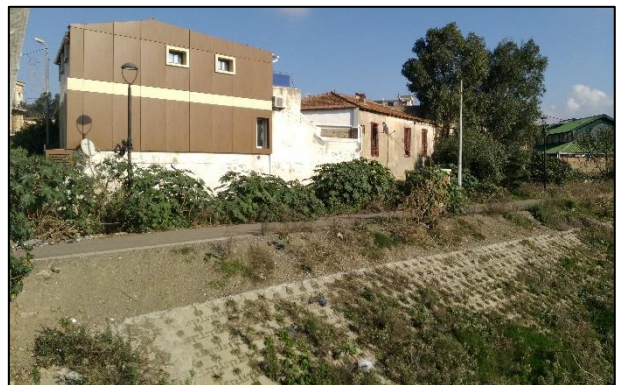
Figure 118 : les berges de l'oued El-Harrach Source : prise par l'auteur le 17/11/2018
