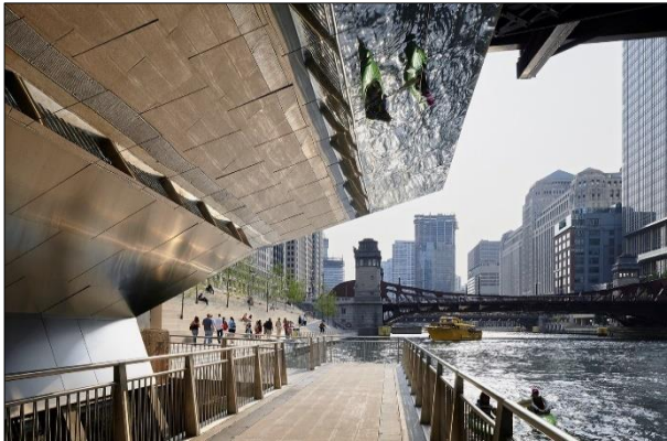
Figure 40 Photo sur le passage flottant sous les ponts mécaniques Source: archdaily.com/
