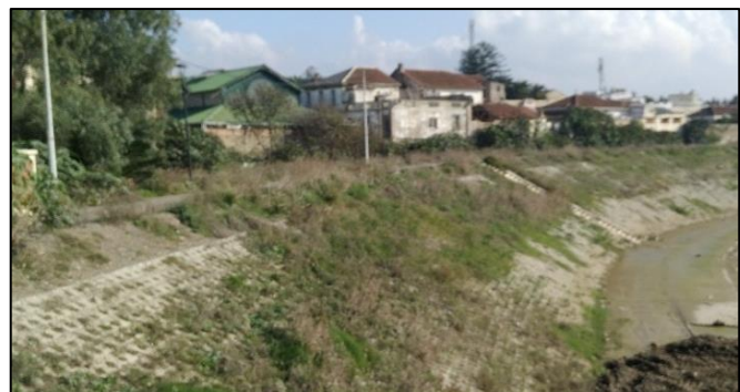
Figure 122 Les berges d'oued El-Harrach Source : prise par l'auteur le 17/11/2018
