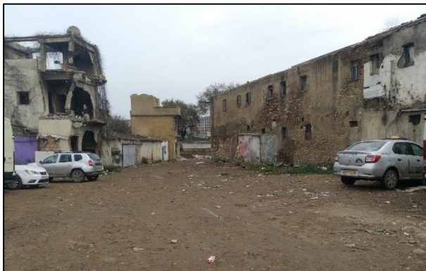
Figure 119: terrain délaissé Source : prise par l'auteur le 17/11/2018
