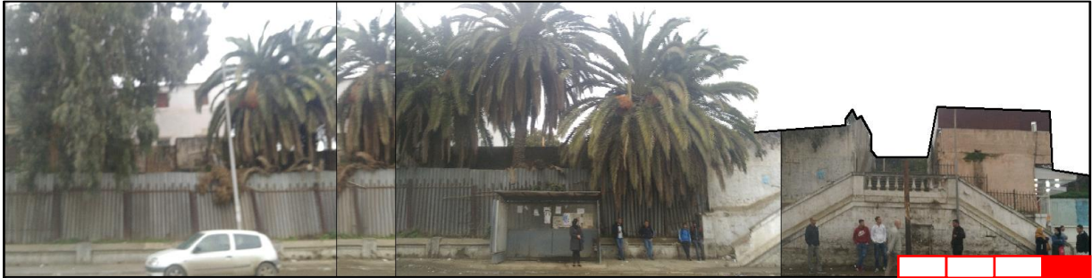
Figure 140: façade ouest en face le site d'intervention Source : prises et traités par l'auteur le 17/11/2018
