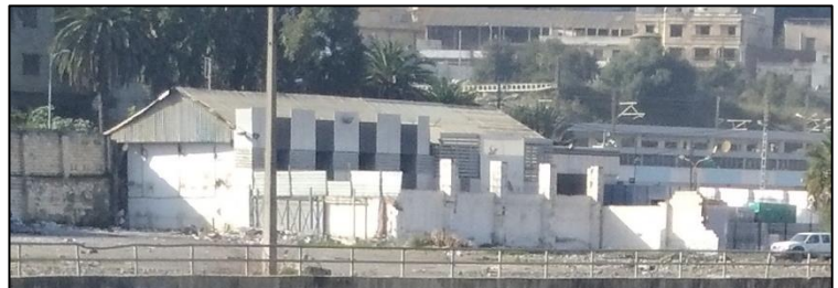
Figure 146 : dépôt abandonné Source : pris par l'auteur le 17/11/2018
