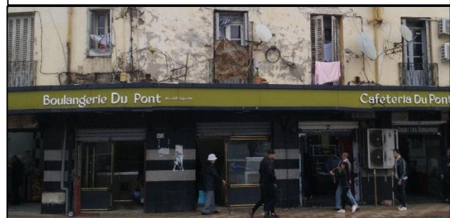
Figure 94 : Boulanger et cafeteria au RDC Source : prise par l'auteur le 17/11/2018
