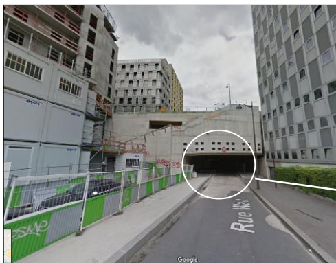
Figure 47 Vue rapprochée sur l'accès mécanique au sous-sol Source: google.com/maps
