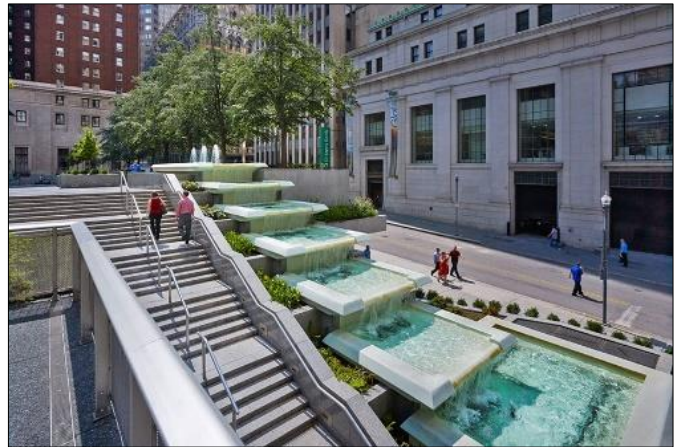
Figure 9 Photo sur les escaliers de la place Source: moderni.co/
