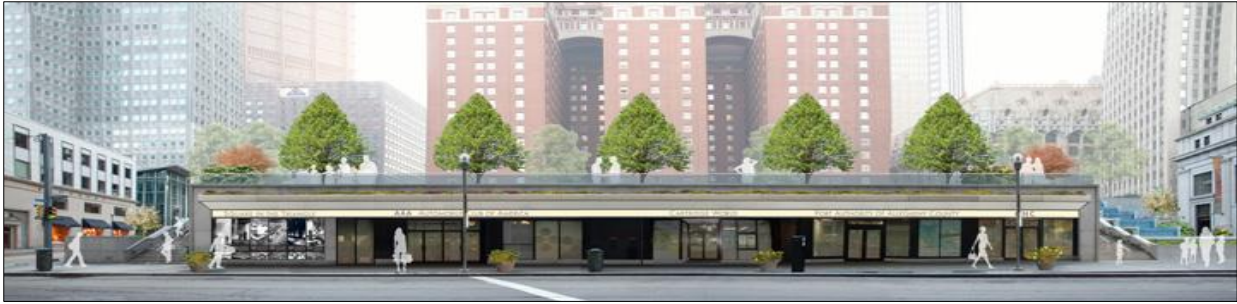
Figure 10 vue de face sur les commerces sous la place Mellon square Source: heritagelandscapes.com/
