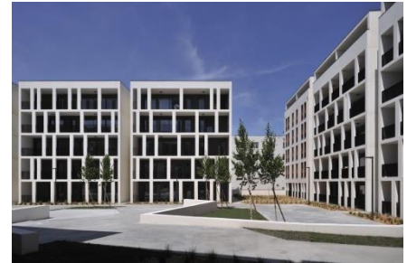
Figure 95 Vue depuis la cour intérieure
