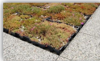
Figure 113 détail de la toiture végétalisée Sedum
