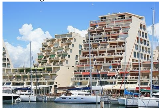
Figure 21: Aménagement des terrasses dégradées orientées vers la mer, La grande motte France
