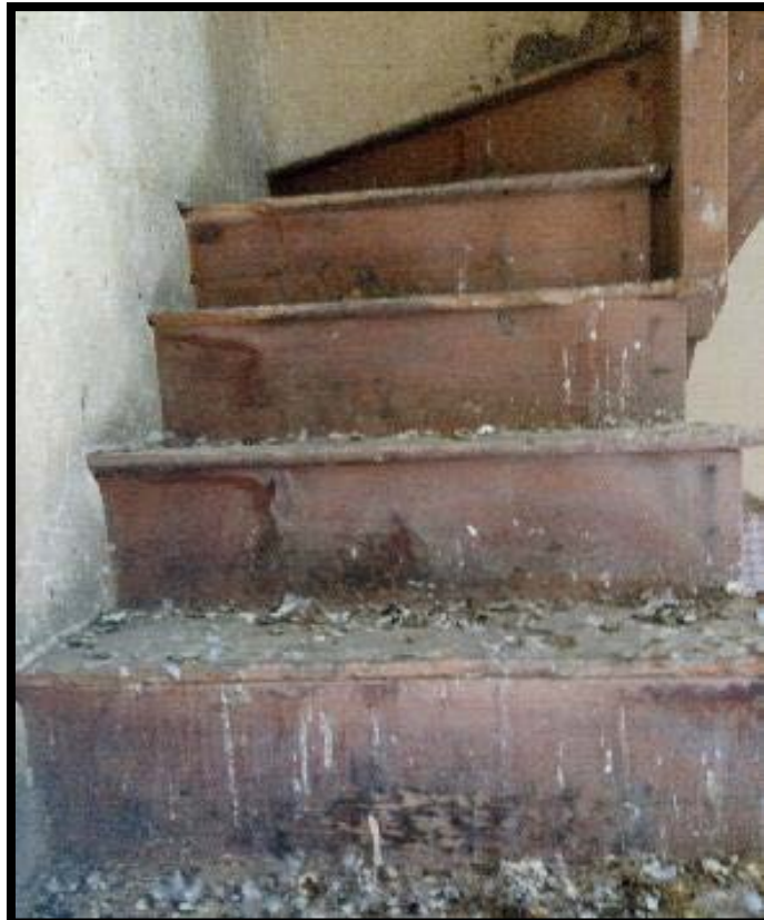
Figure78: photo sur l'escalier du la tour d'horloge de l'hôtel de ville de Mostaganem
