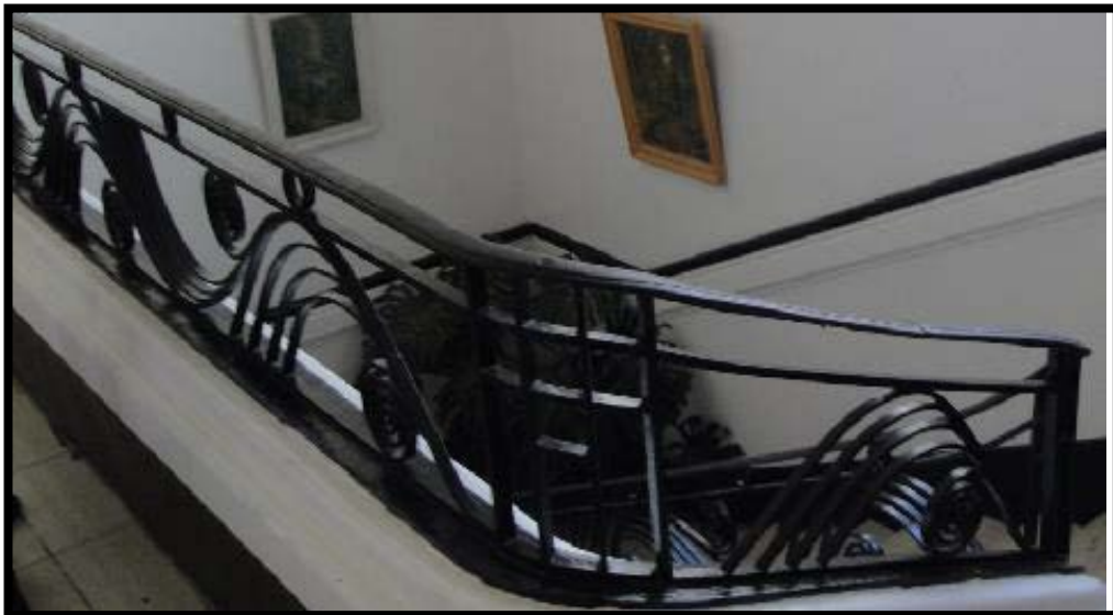
Figure 84 :photo de Garde-corps de la cage d'escaliers de l'hôtel de ville de Mostaganem
