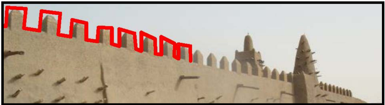
Figure55 : l'ornementation de la mosquée de Tombouctou
