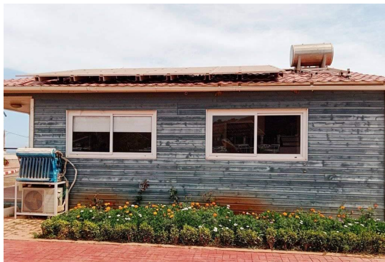
Figure 2.5 : Façade sud de la maison.
