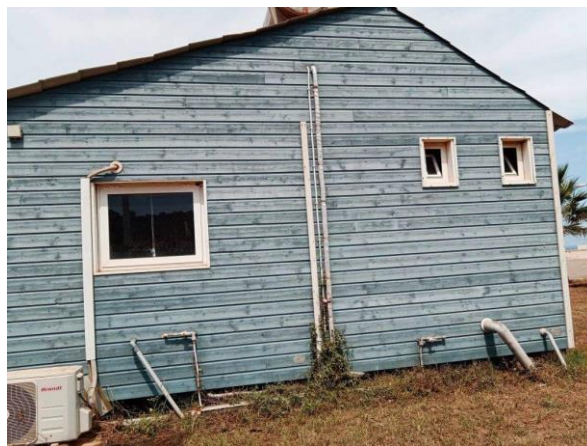
Figure 2.7 : Façade l'est de la maison.
