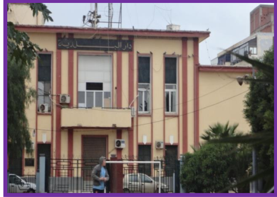
La mairie de la ville. Une architecture coloniale de R+1, des fenêtres en languettes.
