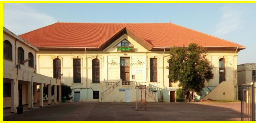
Cet édifice de R+1 avec des fenêtres en languettes et toiture en tuile rouge est à l'origine un casino. Après l'indépendance il a été reconverti à une institut, L'institut actuellement en état de dégradation à cause de l'absence d'entretien.
