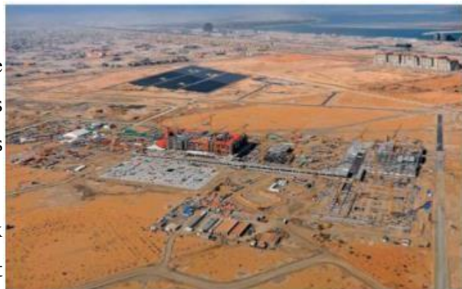
Figure 20 : vue aérienne de masdar city en cours de construction
