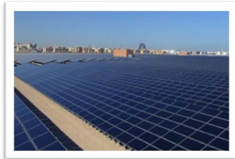
Figure63 : 22 hectares de terres sont dédiés à l'installation de
