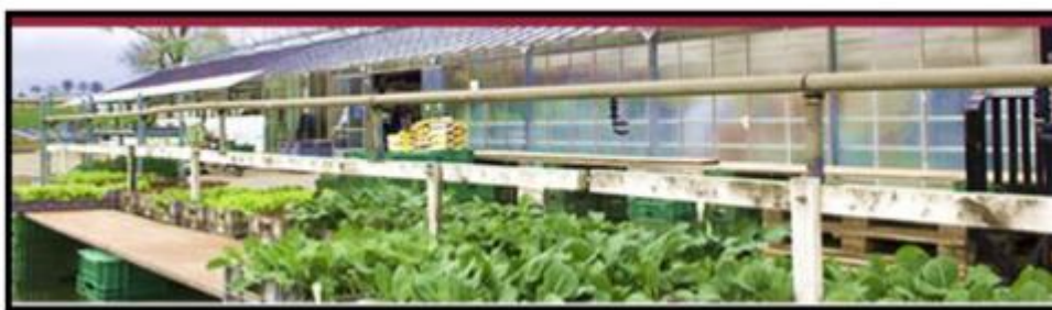
Figure33 : façade de l'institut agricole de Grangeneuve
