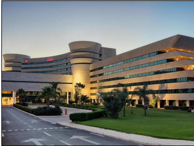
Figure 17 : vue d'ensemble sur l'hôtel
