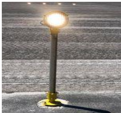
Figure I.6 Balisage lumineux d'approche
