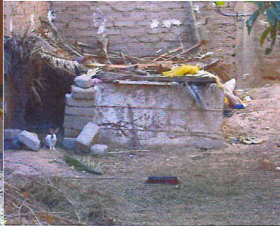
Figure 15: Bâtiment construit en ciment région Foughala, Biskra
