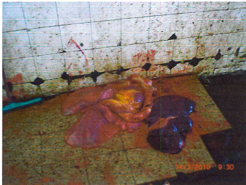
Figure n°04 : Nature et état de propreté des revêtements du sol et de murs. (Photo personnelle)
