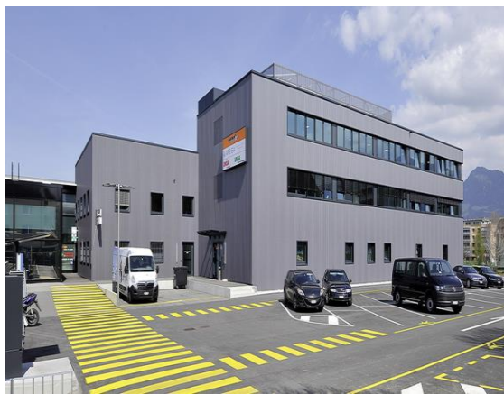
Figure30 : Photo perspective sur le parking et le bâtiment technique
