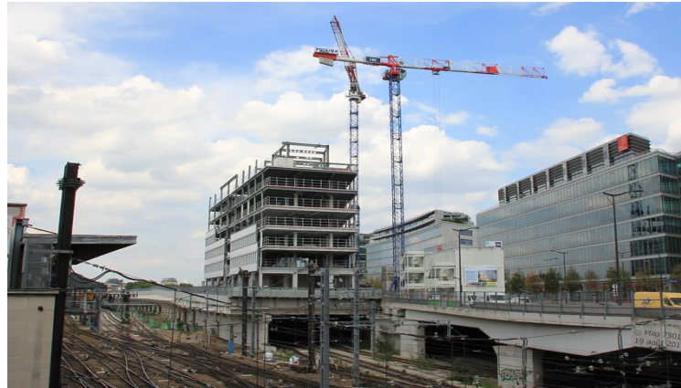
Figure47 : Le projet en chantier
