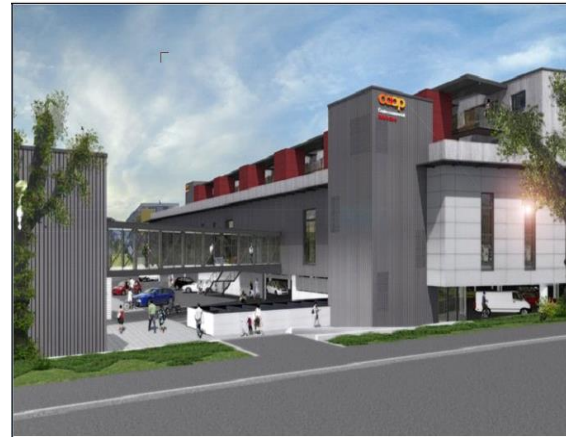
Figure31 : Photo perspective sur la passerelle
