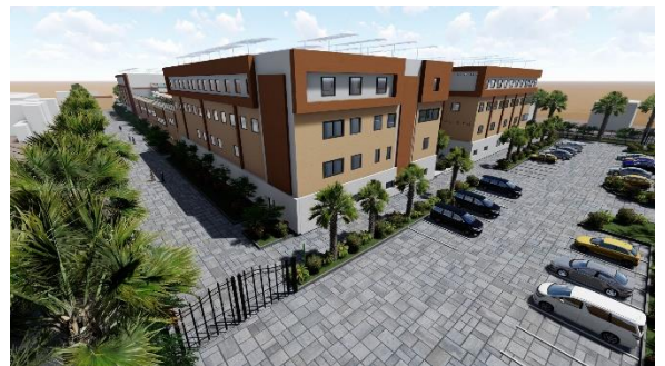
Figure 54 : vue montrant les ouvertures
