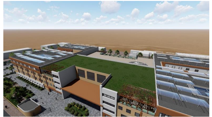
Figure 56 : vue montrant la toiture végétale Source : Auteurs, 2020.
