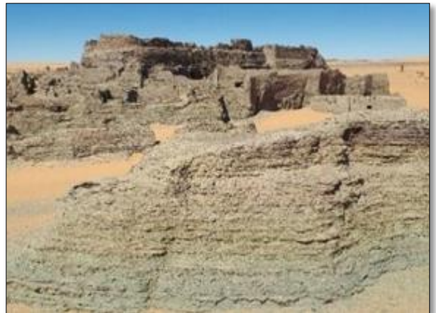
Figure18: reste d'un ksar à Timimoune Source : Google image
