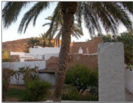
Figure 131: Ksar après restauration Source : M.Ballalou Zoubir
