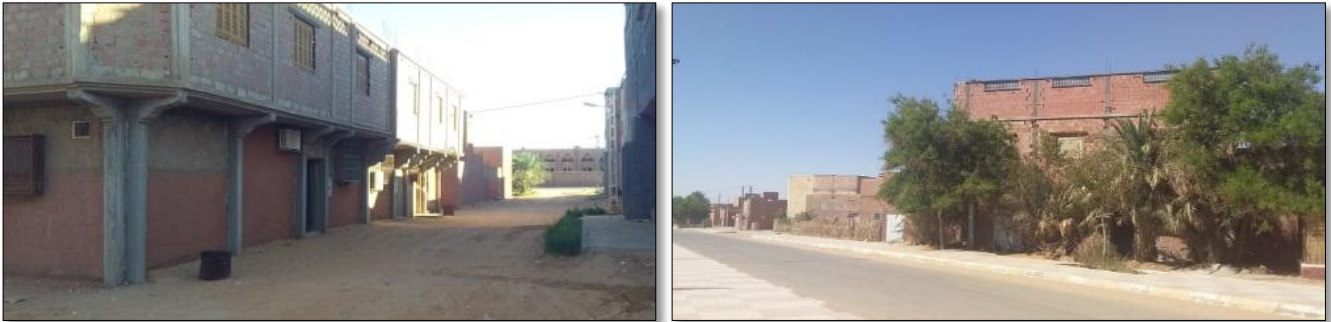
Figure 984 : Des nouvelles constructions source : auteur 2020
