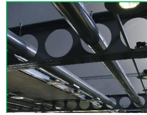
Figure 2.70: poutres alvéolaires Arcelor Mittal .2016
