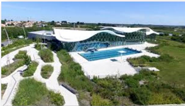
Figure 40 : vue aérien du centre Source : archidaily
