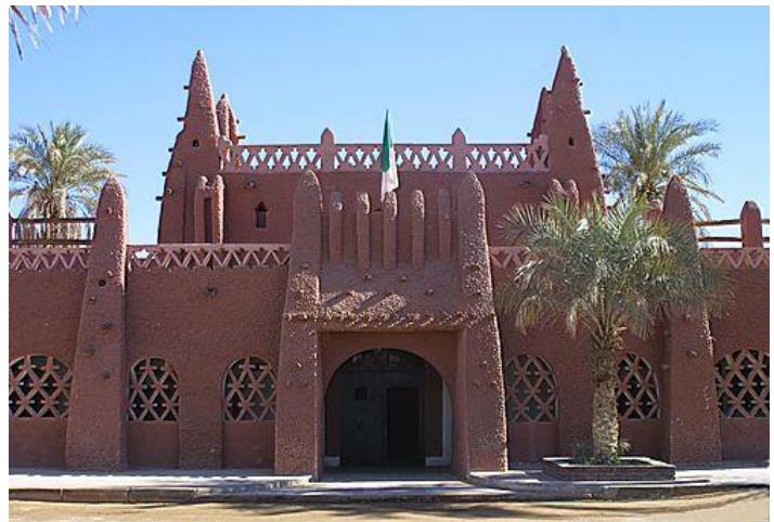
Figure 35: Traitement de façade principale du l'hôtel oasis rouge
