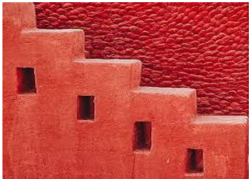
Figure 36 : Enduit en méthode tboulit
