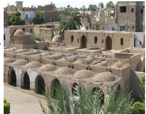
Figure 23: les toitures Source : rapport sur l'état de conservation des biens du patrimoine mondial
