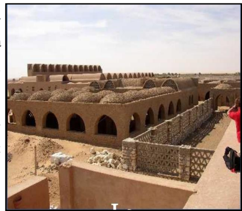
Figure 19: vue sur le village de Gourná Source : rapport sur l'état de conservation des biens du patrimoine mondial
