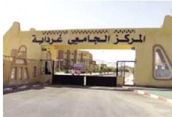
Figure 78: centre universitaire ghardaia Source : Google earth
