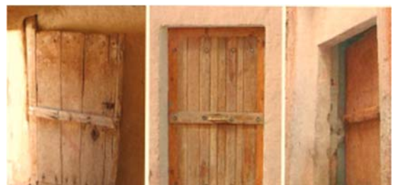
Figure 74 : la boiserie dans les portes et les fenêtres
