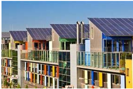
Figure 3: le quartier de Vauban à Fribourg.
