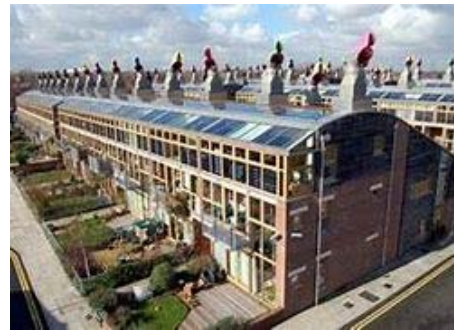
Figure 6: utilisation des panneaux photovoltaïques pour la production d'énergie sur les toits des bâtiments du quartier Bedzed.
