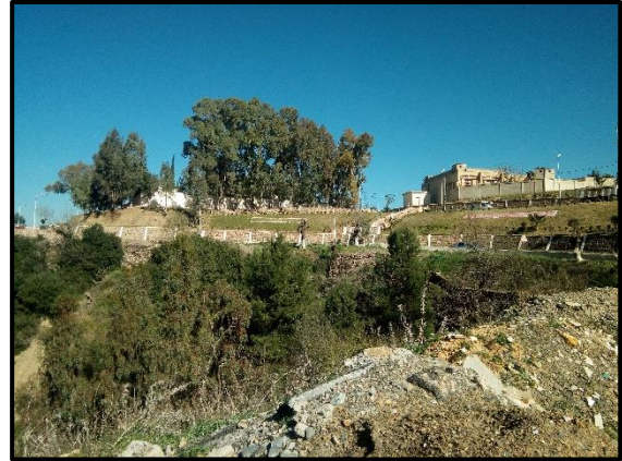
Figure 3 - 26: L'entrée nord du village Source : L'auteur
