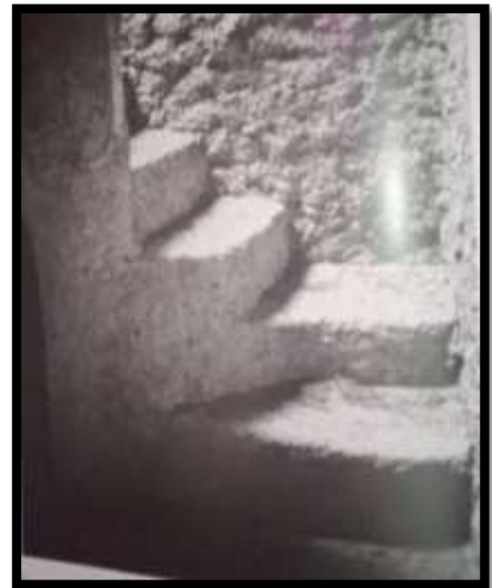
Figure 54 : Escalier Source : une leçon d'architecture
