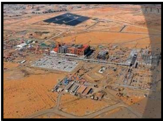
Figure II.86 : début des travaux en 2006 source: Google image
