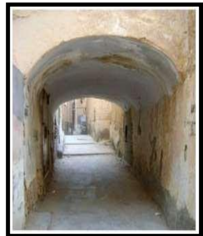
Figure II.77 : Plancher en voute source: Types_de_plancher_dans_les_constructions_traditionnelles_dans_la_vallée_du_M'zab PDF
