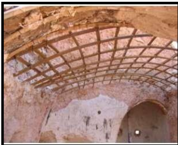
Figure II.76 : travaux de restauration d'une voûte dans la tour Zelliga – Béni-Isguen Source :Types_de_plancher_dans_les_constructions_traditionnelles_dans_la_vallée_du_M'zab PDF
