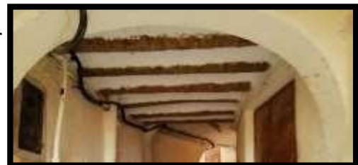
Figure II.73 : poutre source: visite des étudiantsmaster2 promo 2019-2020
