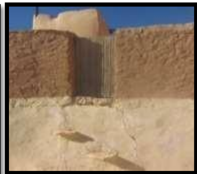
Figure II.62 : porte dans la terrasse source: visite des étudiants master2promo 2019-2020
