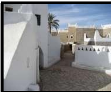
Figure II.104 : impasse au terrasse. Source: https://maison-monde.com/maisons-traditionnelles-Ghadames
