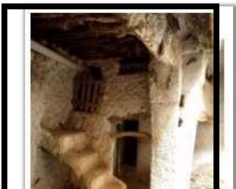
Figure II.80 : plancher incliné source: Types_de_plancher_dans_les_constructions_traditionnelles_dans_la_vallée_du_M'zab PDF
