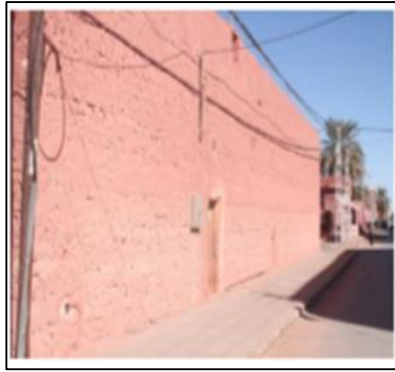
Figure 4.30 : Photo montrant la façade d'ancienne construction Source : Mémoire de fin d'étude.
