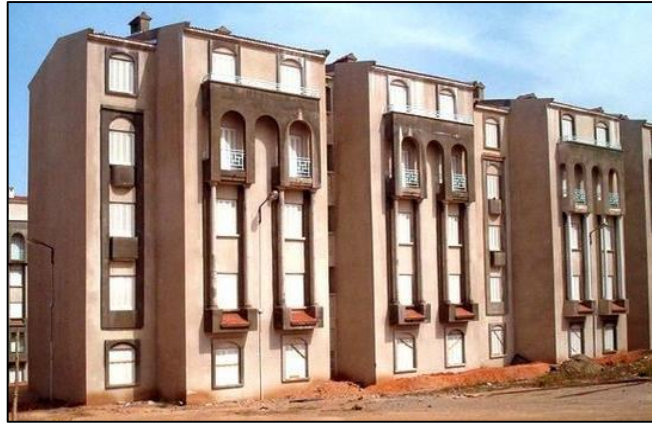
Figure 1-2.4 : Photo d'une ville au Sud algérien à Timimoun. Avec les mêmes caractéristiques d'une ville au Nord Source : Google image.
