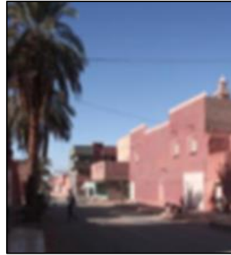
Figure 4.29 : Photo montrant la façade de nouvelle construction Source : Mémoire de fin d'étude.
