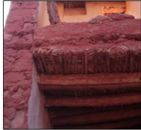
Figure 4.24 L'utilisation du palmier dans la construction Source : Guide de réhabilitation de l'habitat en terre à Timimoune.
