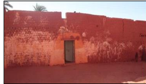
Figure 4.21 : Photo montrant le gabarit. Source : pdau traité par l'auteur
