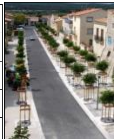
Figure 1-2.8 : Photo du boulevard des Acquières : au centre Bourg de Vic-la-Gardiole- France. Source : Google image.
