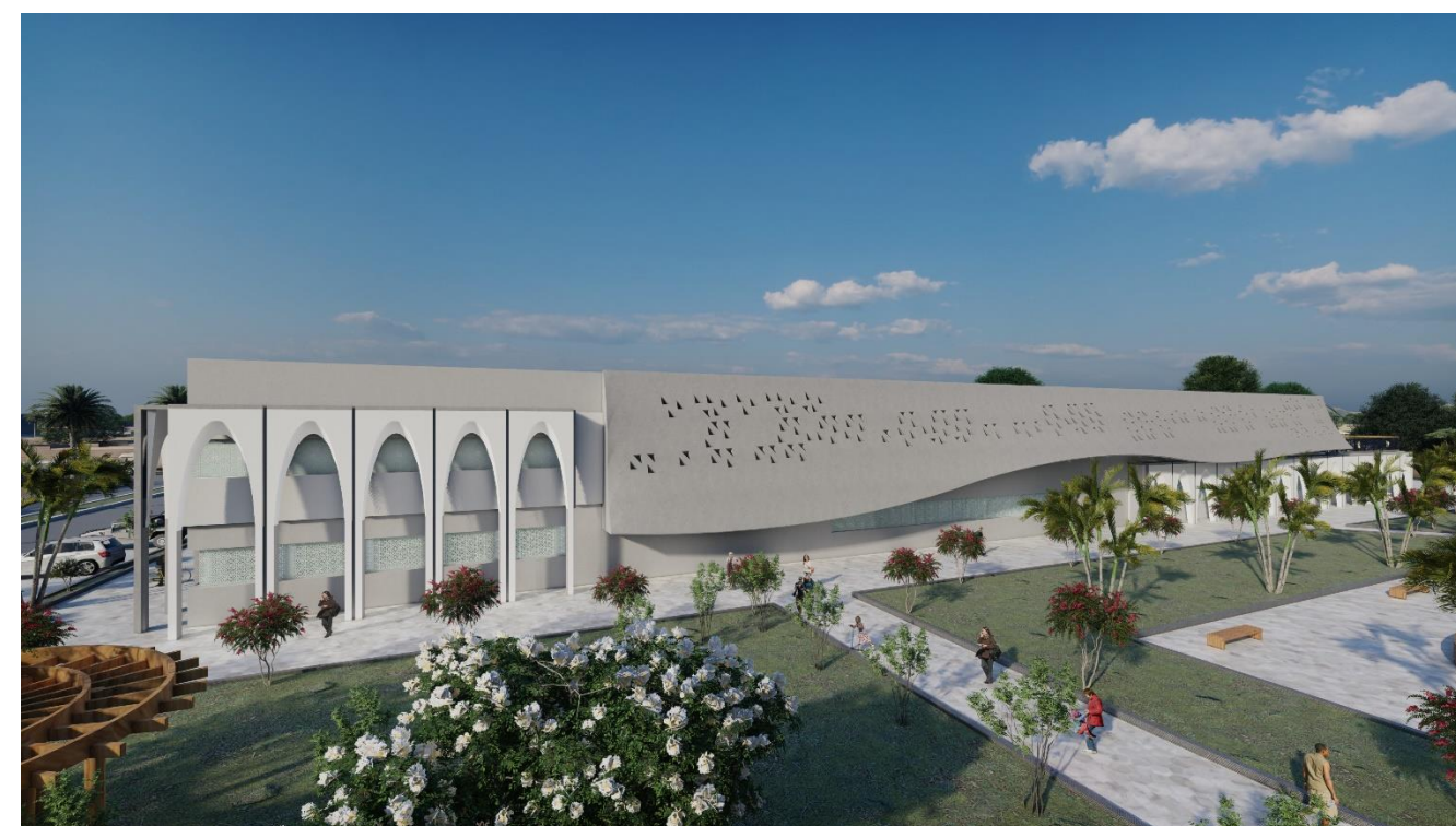
Figure 6.75 : vue sur la façade nord
