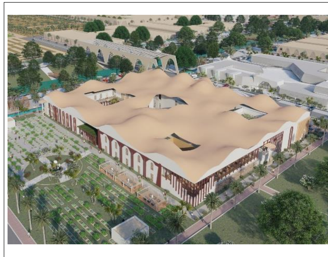
Figure 6.54 : Capture sur la toiture du projet Source : Auteurs, 2021
