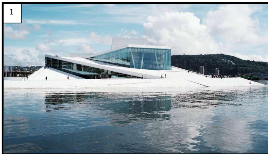
Figure 18: image et localisation de l'opéra d'Oslo
