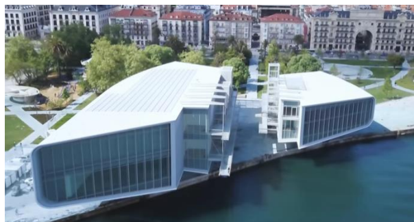
D. Vue sur la percée qui relie la ville à la mer.
