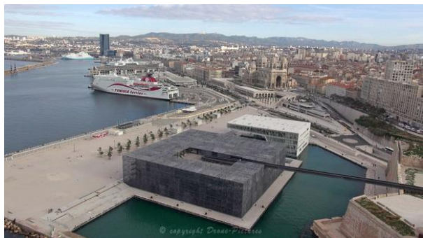
B. Traitement de façade Sud et façade Ouest du en résille de béton MuCEM. Source : https://www.drone-pictures.fr/image-fixe-tournage/h2C8AFF44#h2c8aff44 . Consulté le 07.02.2019
