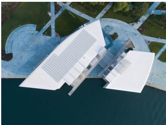
A. Vue de dessus qui montre le traitement de la toiture et le système des passerelles.
