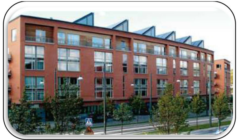
FIG n°50: Les panneaux photovoltaïques
