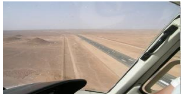
Figure III 5: la RN 01 Source : opvm de Ghardaïa
