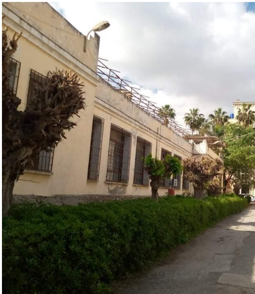
Figure 36 : Photo réelle sur la façade Nord
