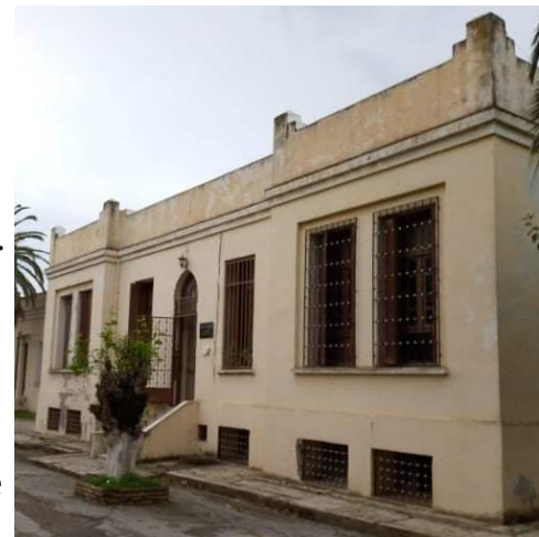
Figure 38 : Photo réelle sur la façade Est
