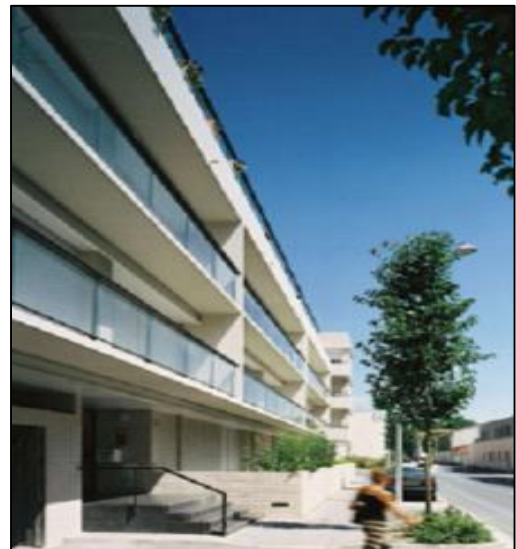
Figure 9: Les balcons au niveau de la façade
