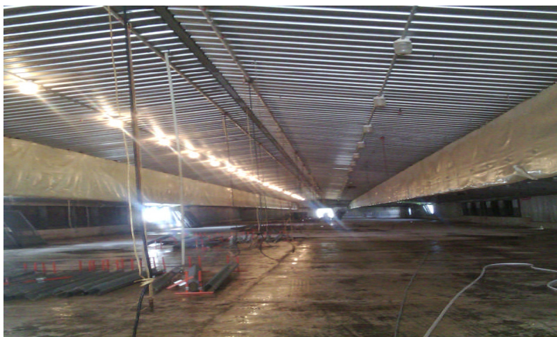
Figure 15 : Les travaux effectués avant la réception des poussins.
