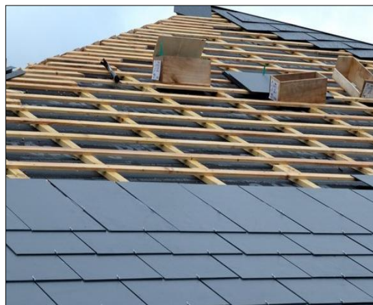
Fig185. Toiture en ardoise
