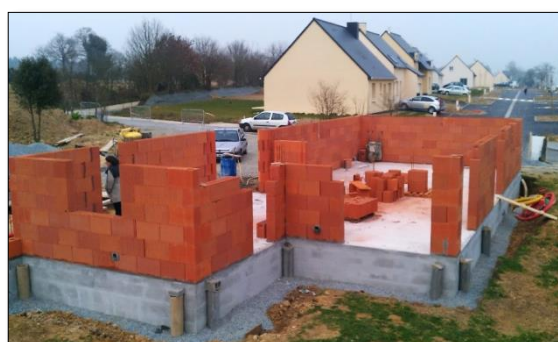
Fig54. Système constructif mono mur
