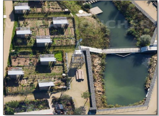
Fig22. bassin de rétention dans l'Eco quartier de la bottière chénaie. Nantes
