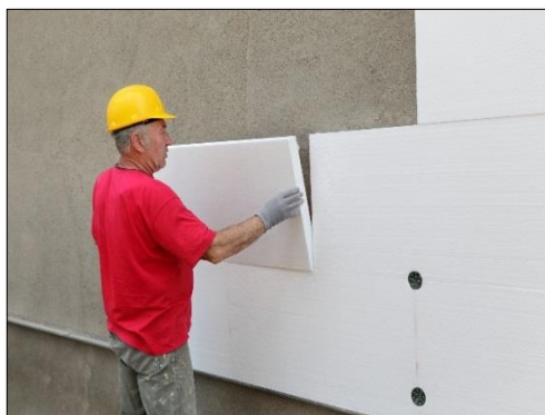
Fig173. La pose du polystyrène
