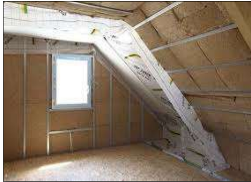
Fig99. Prévoir l'étanchéité adéquate aux effet d'humidité
