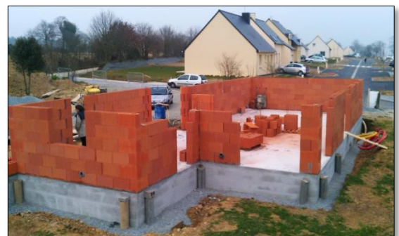
Fig66. Système constructif mono mur
