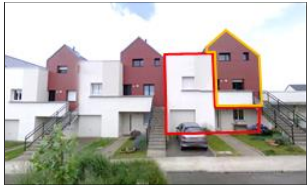
Fig50. Etude formelle du bâti
