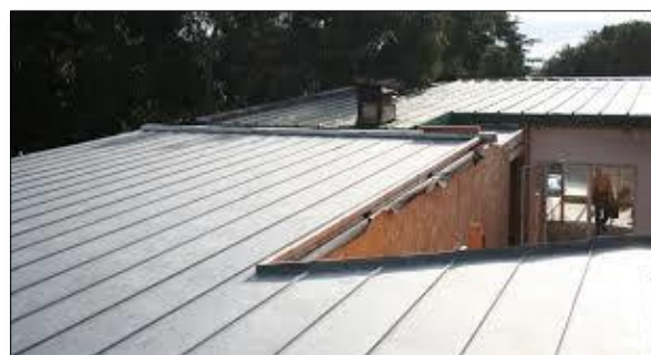
Fig55. Couverture en zinc
