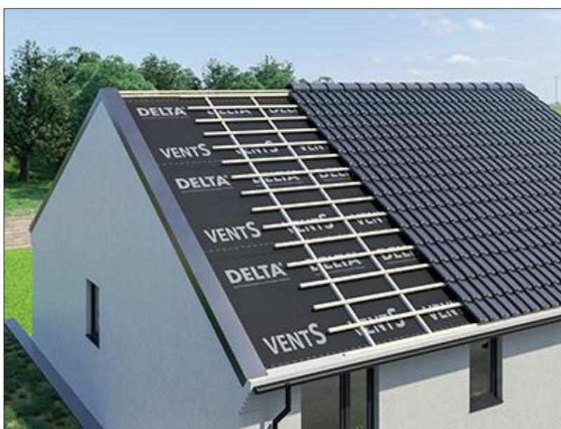
Fig. La pose de l'écran d'étanchéité sous toiture source : Google image
