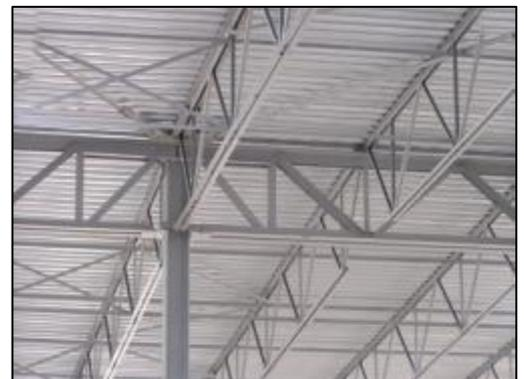
Figure196 : poutre treillis
