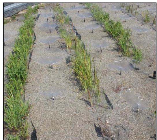
**Figure 64 : les pulvérisateurs de bassin d'épuration**
