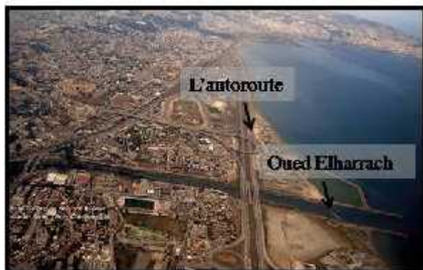
Figure 15 : Oued Elharrach avant le réaménagement (traitée par l'auteur) Source : Google Earth
