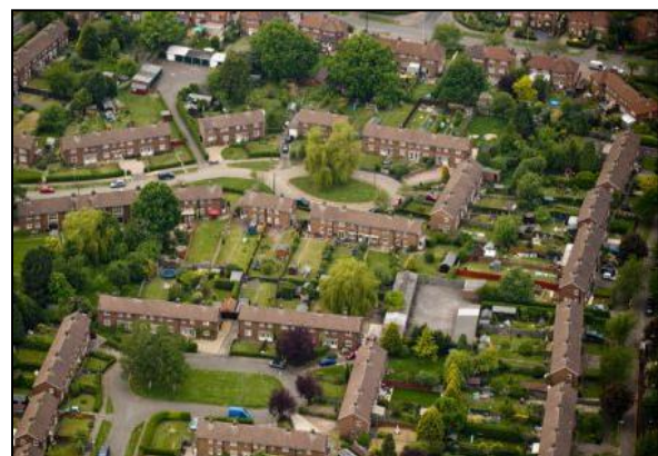
Fig 2.1: Unité de structuration – les « estates », Welwyn Garden City.
