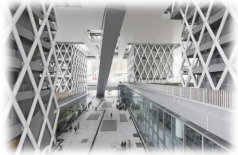
Fig 3.38: vue sur la cour centrale
