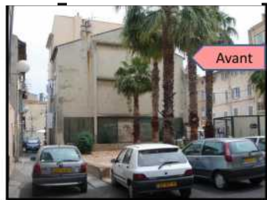
FIGURE II.29 : La place Bourradet avant les travaux
