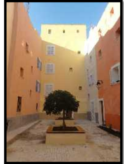
FIGURE II. 10 : APRES TRAVAUX L'ouverture vers un espace commun convivial en cœur d'îlot
