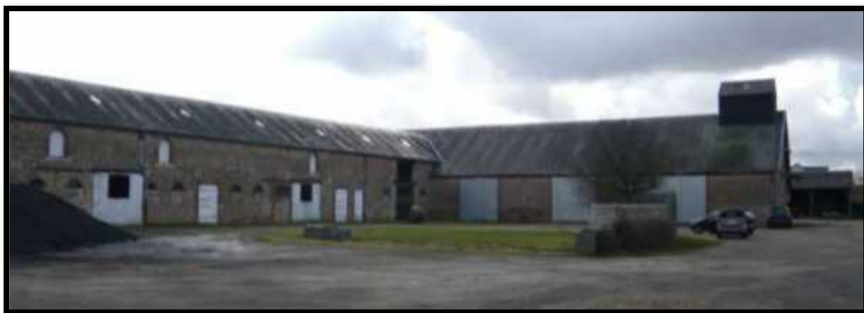
FIGURE II.32 : Vue de la ferme - l'état initial
