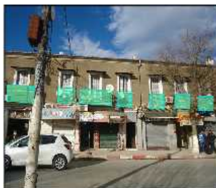
FIGURE III.78 : La présence des balcons alignés dans la façade
