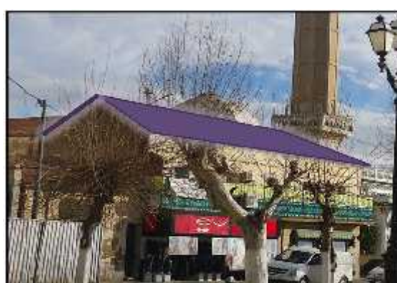
FIGURE III.76: Toiture en double versant en tuile
