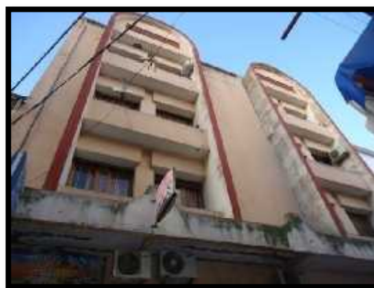
FIGURE III.105 : façade Sud de la maison
