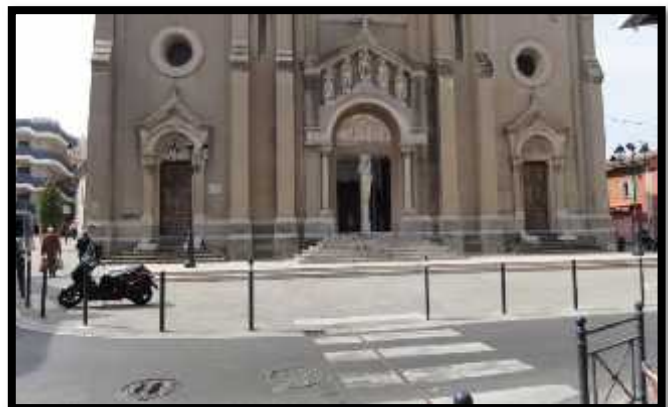
FIGURE II. 18 : Le parvis de l'église après travaux
