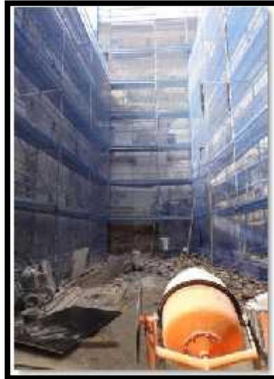
FIGURE II. 09 : Travaux de démolition de l'immeuble insalubre central à l'îlot. Composition
