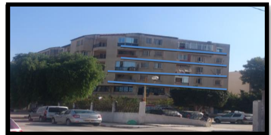
Figure 3.57 : façade de nouvelle extension
