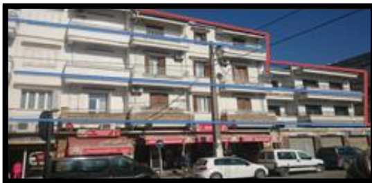
Figure 3.56 : façade de nouvelle extension
